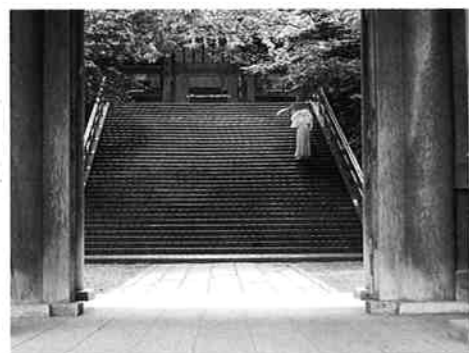
(改修予定の楼門内石畳)
