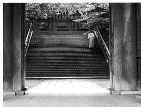
(改修予定の楼門内石畳)
