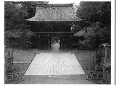
石畳・照明を新設
